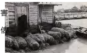
米俵による土囊積み
