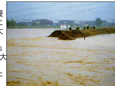
破堤した五十嵐川
